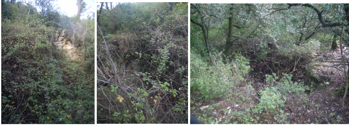
Figure 3: Photos d'un effondrement à Belcodène Vue en galerie et effets en surface (secteur difficile d'accès)
